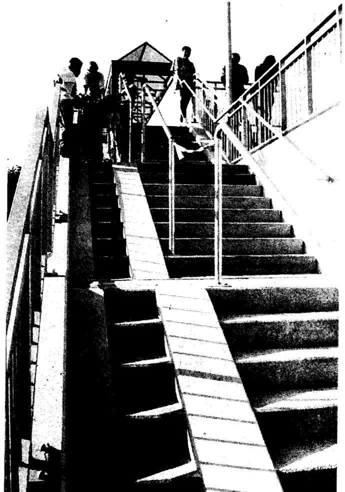
Foto: Zu steile Treppen an Neubauhaltestellen erschweren die Benutzung der Stadtbahn an manchen Bruchsaler Haltestellen. Rampen wären besser.
