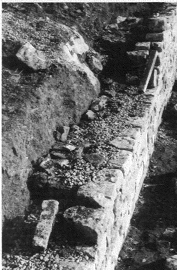
Behauene Steine bilden die glatte Außenwand der Trockenmauer. Sie wird mit losen Gesteinsmaterial hinterfüllt. Split verhindert die Einschwemmung von kostbarem Erdreich und beläßt die guten Drainageeigenschaften der Schüttung. (Foto: Hajo Rheinstätter)
