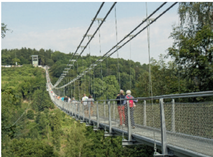
Abb. 2: Die Hängebrücke über der Rappbodetalsperre im Harz.
